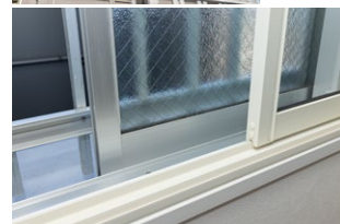
全住戸の内窓設置を実施
