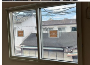
主居室の南側に内窓設置
